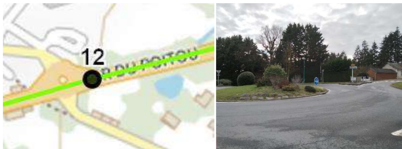
Figure 177 : Point de vue 12 – Traversée d'un rond-point
